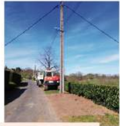
Après travaux : Poteau bois neuf, Cable de réseau remis en place, Poteau béton redressé
