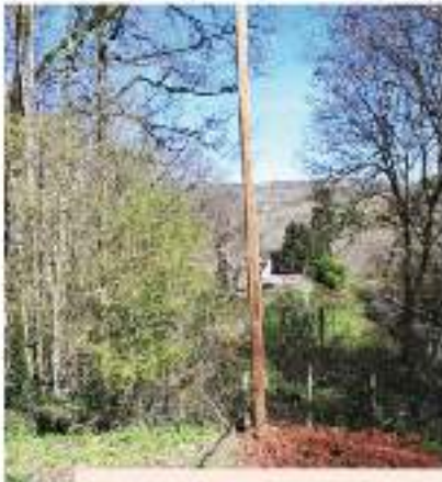
Après travaux : Poteau bois neuf, Cable de réseau remis en place, Poteau béton redressé
