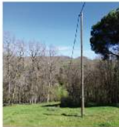
Après travaux : Poteau bois neuf, Cable de réseau remis en place, Poteau béton redressé
