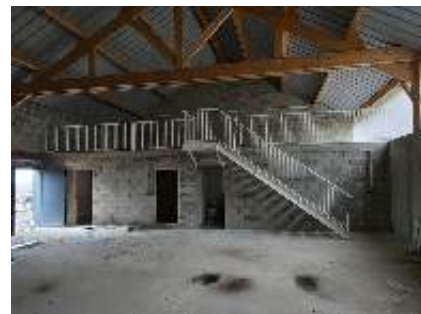
L'escalier d'accès à la mezzanine du local technique est installé.
