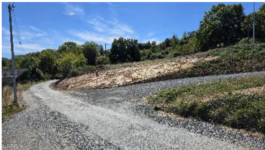
Aménagement et sécurisation accès nouveau bâtiment communal
