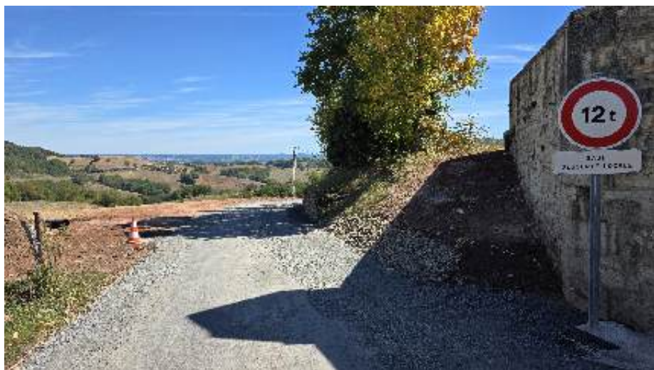
Aménagement et sécurisation du virage du cimetière
